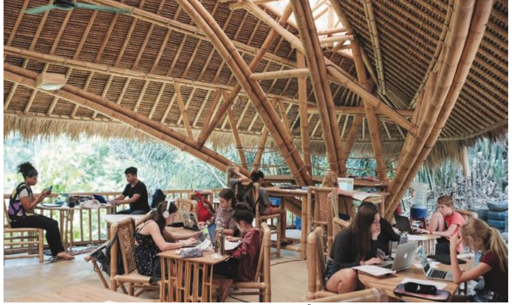
Green School'da plastik kullanımı neredeyse yok, binanın tamamına yakını bambudan inşa edilmiş. Özel teknikle bambunun ömrü 50 yıla kadar uzatılmış.
