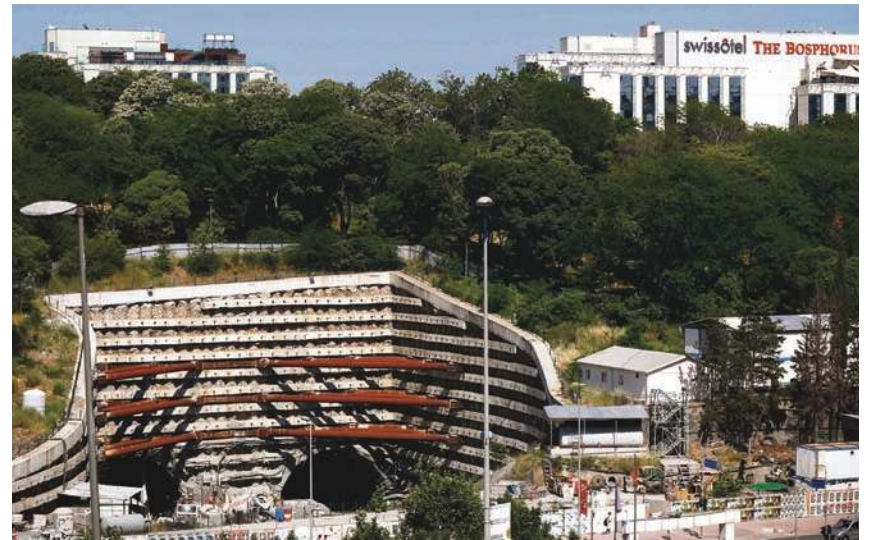
3 bin 900 metre uzunluğundaki tünelin inşaatı için Maçka Parkı'nda şantiye kuruldu.
